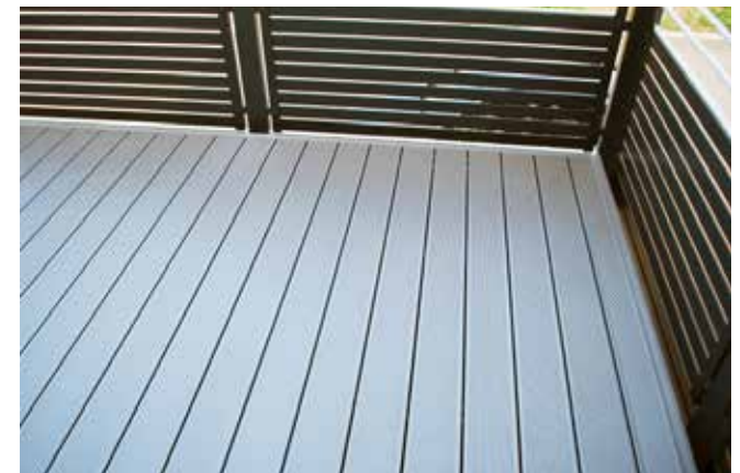
verlegte Fläche ohne Stoß
