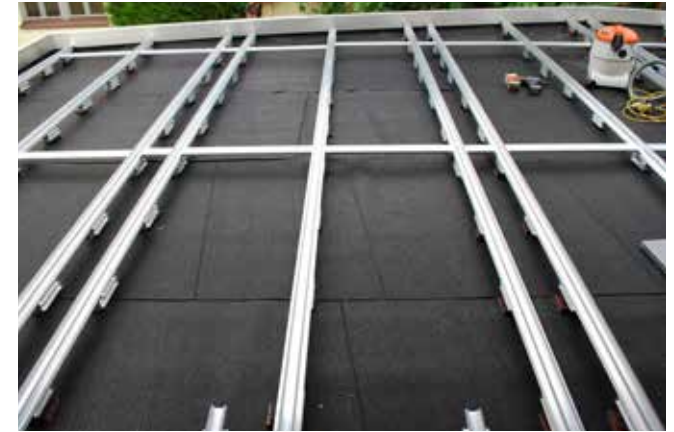
Unterkonstruktion für Verlegung im Halbverband
