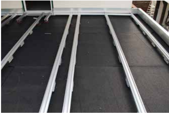
Unterkonstruktion max. Abstand 80 cm
