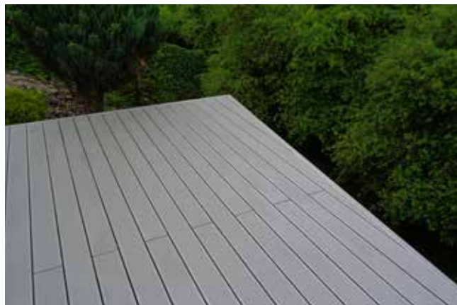
verlegte Fläche im Halbverband
