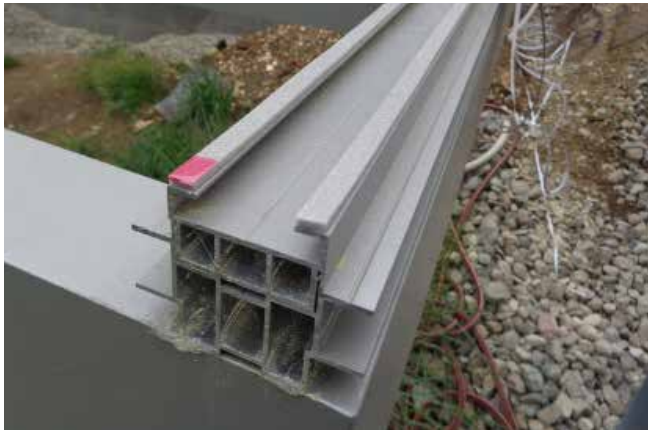
doppelte Unterkonstruktion mit Trittschallband
