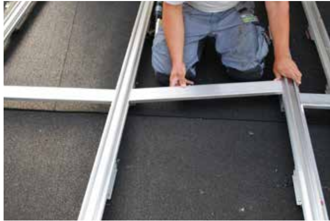
erhöhte Unterkonstruktion mit Aussteifung
