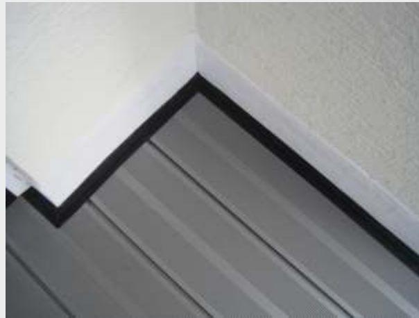
Wandanschlussgummi mit glatt verputzter Wand
