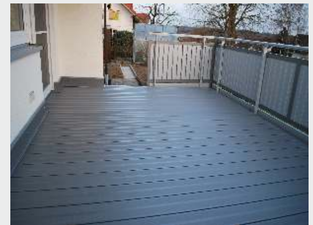
verlegte Fläche mit Geländer
