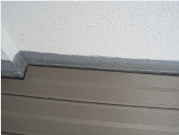
Wandabstand für Gummidichtung
